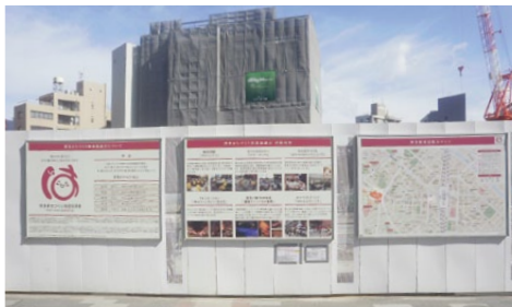
第2キャナルシティ博多工事用仮囲い
